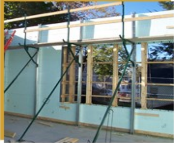
4.Align Wall For Concrete Pour
